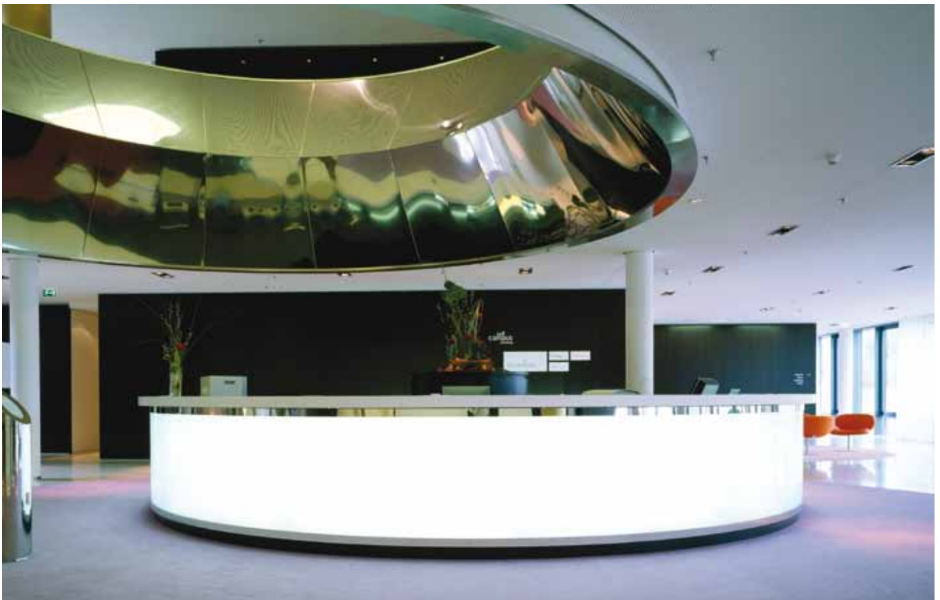
■ Campus Kronberg Theke, Tragekonstruktionen, Einfassungen und Ummantelungen aus Edelstahl
