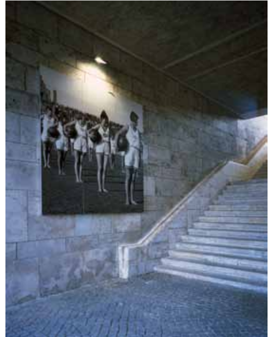
Alu-Paneel mit aufgeklebter Bildfolie und Möbel aus anodisiertem Aluminiumblech
