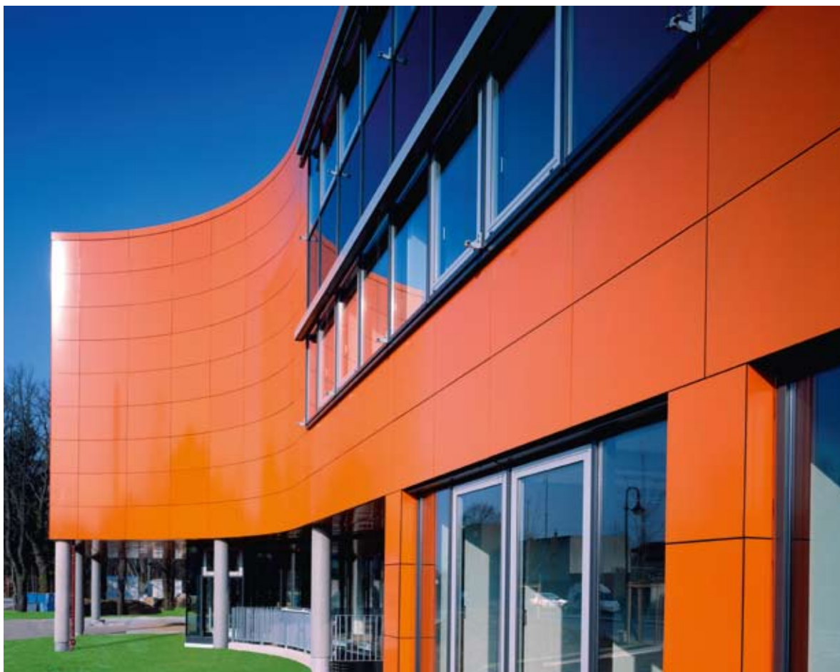
■ Sixt Pullach Aluminium 4 mm scharfkantig, teilweise gebogen
