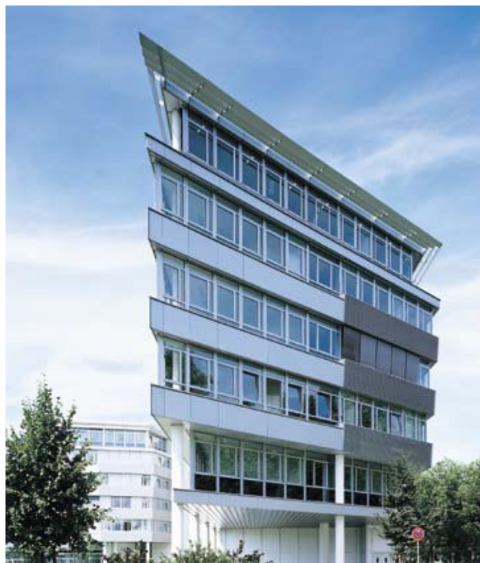
■ Luisenpark Mannheim Feststehender Sonnenschutz, Alu-Lamellen zu einem geschlossenen Dreieck gekantet
