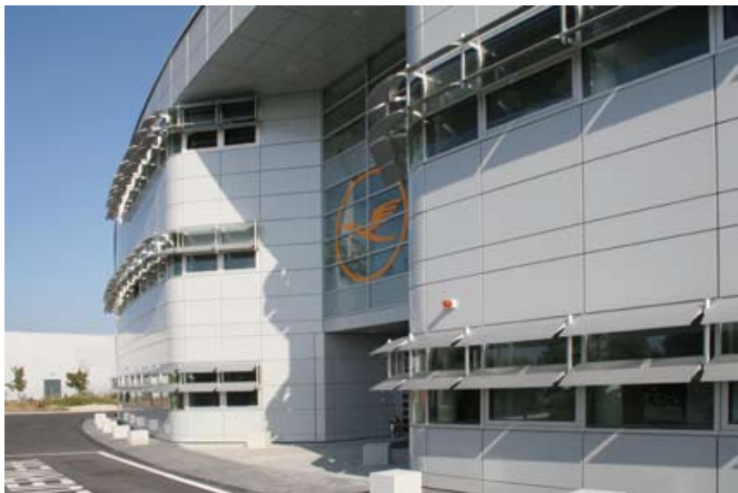
■ Lufthansa Flight-Training-Center Wien Fassadenverkleidung dem gebogenen Wandverlauf angepasst, Aluminium, 3 mm, RAL 9006 pulverbeschichtet
