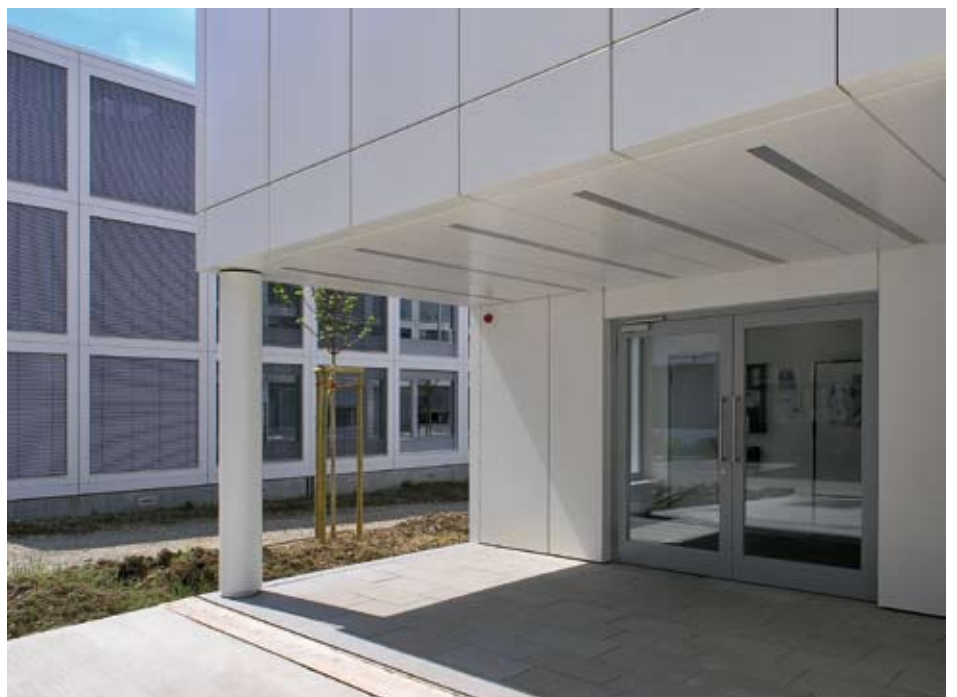
■ Hoffmann-La Roche Kaiseraugst Modulverkleidung aus Aluminium, 3 mm pulverbeschichtet
