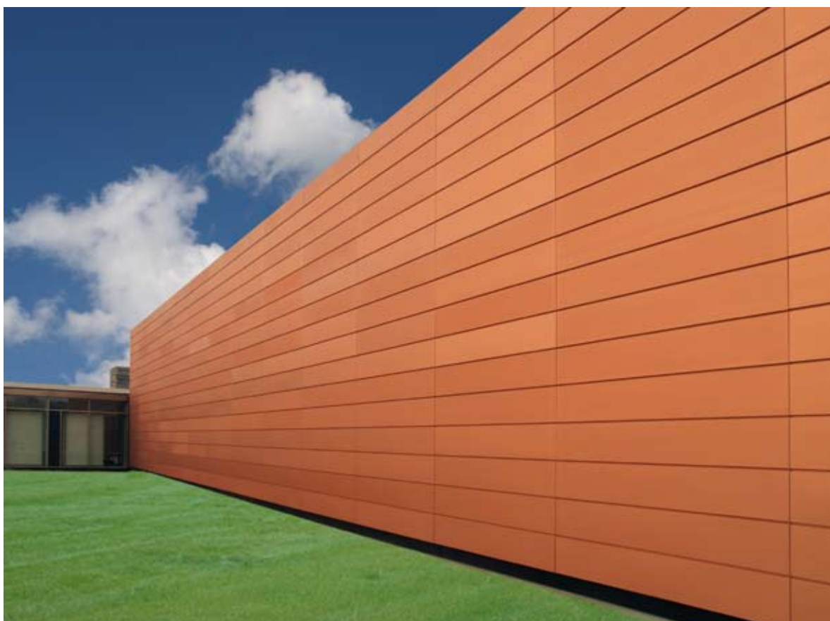
■ SIT Heidelberg Außenfassade aus Kupfer, klarlackbeschichtet
