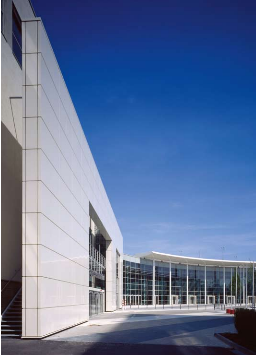
■ Messe, Köln Wandscheibenverkleidung, 3 mm starke Alukassetten mittels Bolzen unsichtbar auf einer Stahlkonstruktion befestigt, Vordach mit gebogener Untersicht
