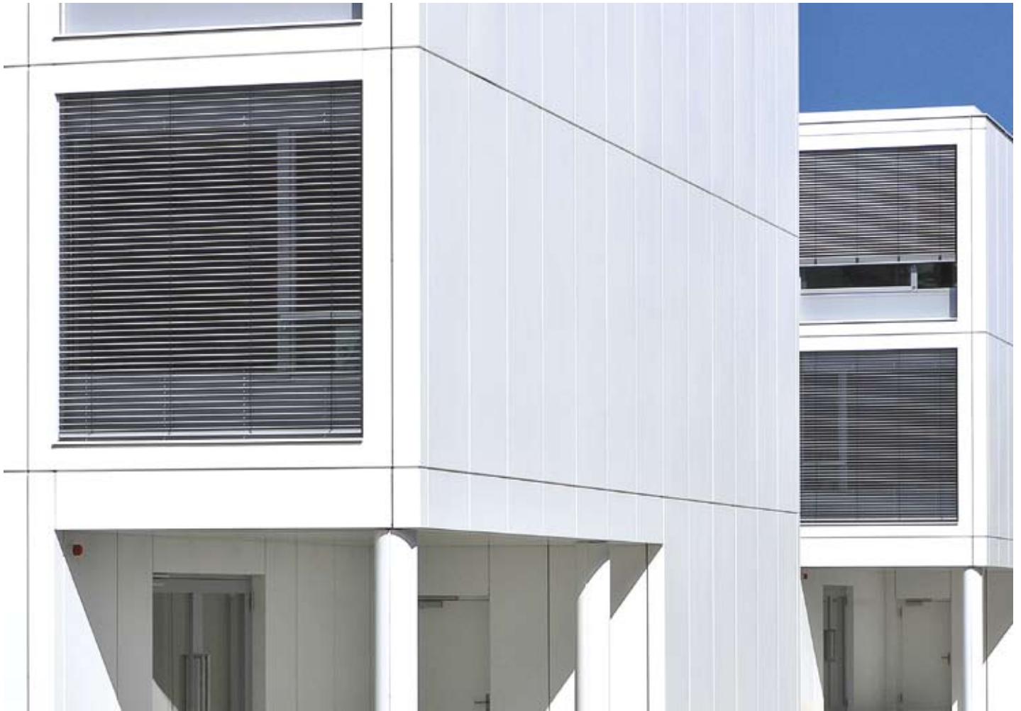
■ Hoffmann-La Roche Kaiseraugst Modulverkleidung aus Aluminium, 3 mm pulverbeschichtet
