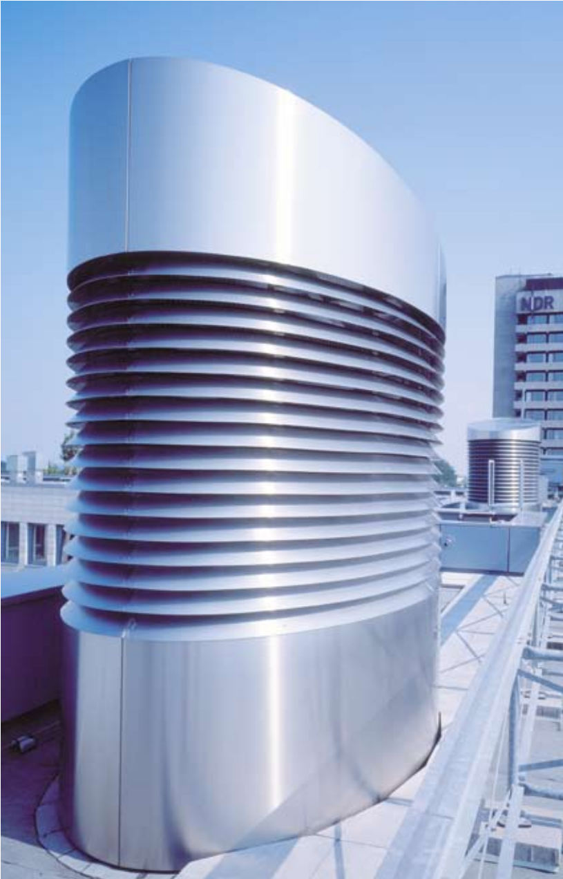
■ Lüftungsturm in elliptischer Form mit Fächerlamellen Typ 1205 Objekt: NDR, Hamburg Architekt: Bechloff, Derfler, Steffen BDA Hamburg
