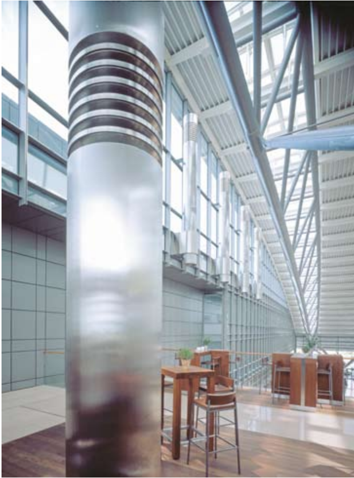
■ Zu- und Abluftsystem Objekt: Terminal 1, Flughafen Hamburg Architekt: GMP, Hamburg Planer: Ridder Mayn Nuckel, Norderstedt
