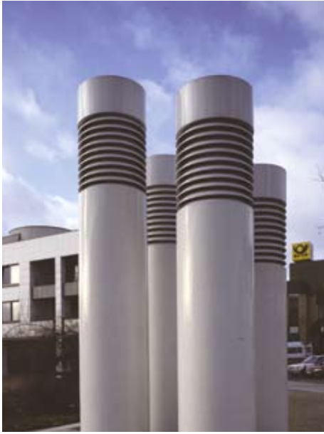
■ Außenluftansaug-/Fortluftturm Objekt: Rathaus Völklingen Architekt: Stadtbauamt, Völklingen
