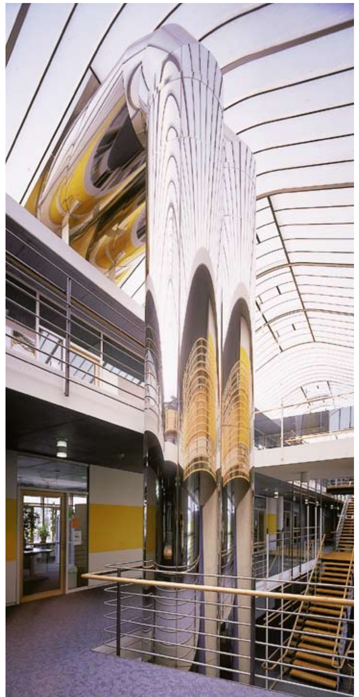
■ Zu- und Abluftsystem Objekt: LVA Lübeck Architekt: Ingenieur-Gesellschaft Rentsahler & Riedesser, Stuttgart
