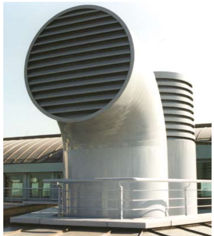
■ Turm aus Aluminium mit Segmentbogen, maximale Segmentbreite 100 mm, dahinter Turm mit Lamellenkopf Typ 1200, Beschichtung in RAL-Farbton Objekt: Pharos-Haus, Wien
