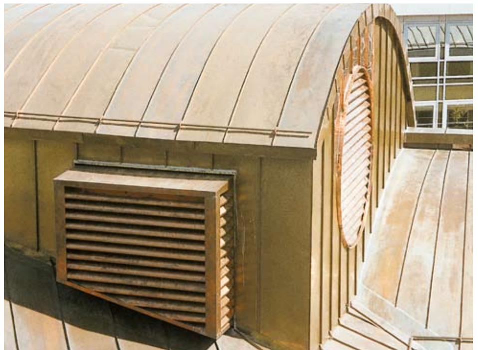
■ Rundes und trapezförmiges Wetterschutzgitter aus Kupferblech
