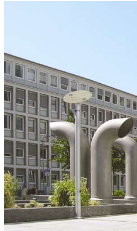
■ Zu- und Abluftsystem aus massivem Rohr und Rohrbögen Objekt: Skylight, Frankfurt am Main Architekt: Richard Rogers, London
