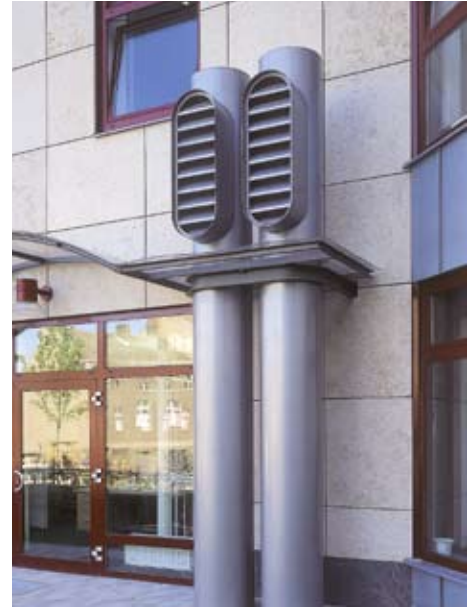
■ Zu- und Abluftturm Objekt: Kreissparkasse Fürstenwalde Architekt: N. Kierdorf, Leichlingen
