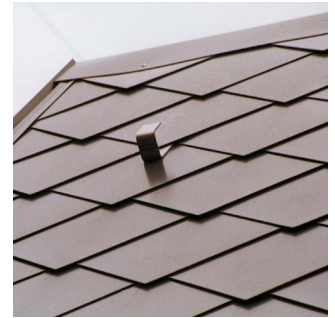
Dachfirst mit Abdeckung
