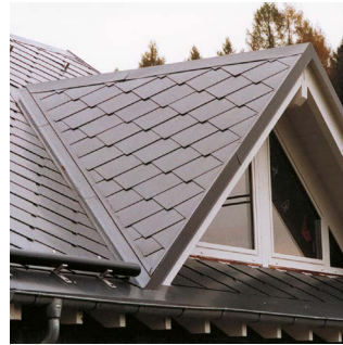
Dachgaube mit Kehlanschlüssen
