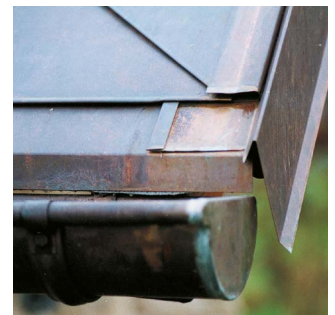
Eckanschluß mit Startschindel, Start- und Randprofil und Ortgang
